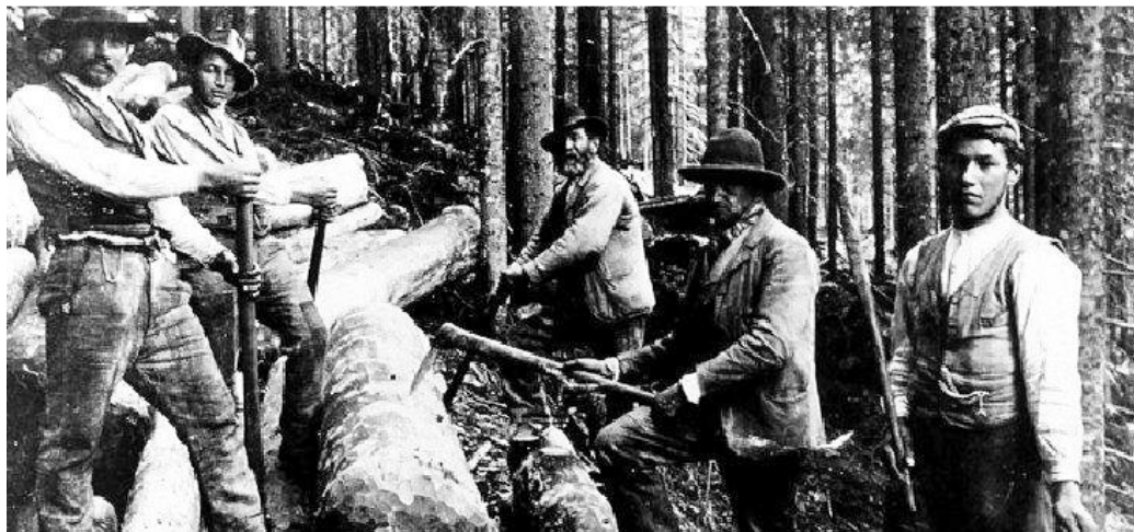
Abb. 42 Bekannt für ihre Fertigkeiten in der Holzbringung: Waldarbeiter der Magnifica Comunità. Foto Archivio Magnifica Comunità di Fiemme Cavalese
